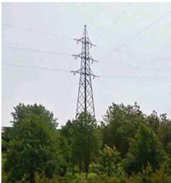
sostegno numero 45 dell'elettrodoto DT dato dalle linee elettriche numero 180 e 635 (sostegno di aggancio delle singole linee in ST)
